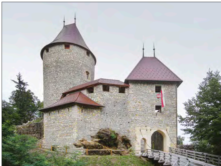
1. Burg Sannegg, heutiger Zustand
